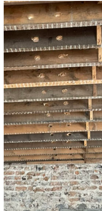
High voltage (230V) und Low Voltage (LAN/TV/etc.) getrennt
