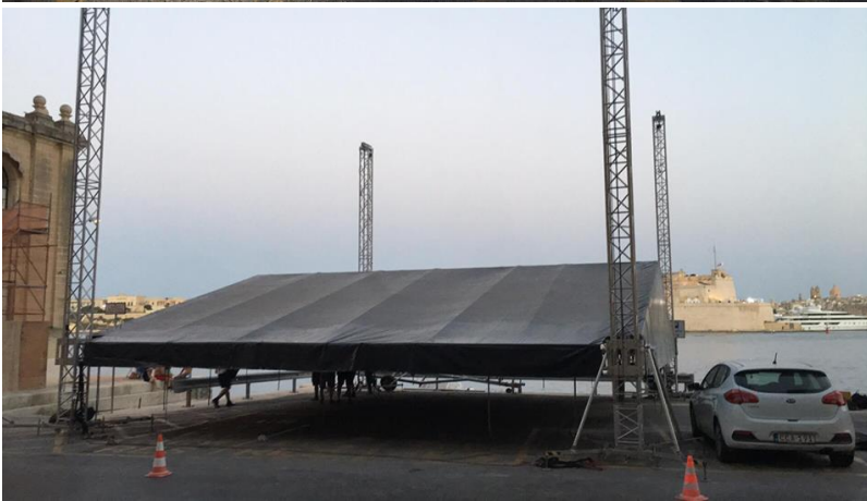
Bühnendach auf Trussystem
