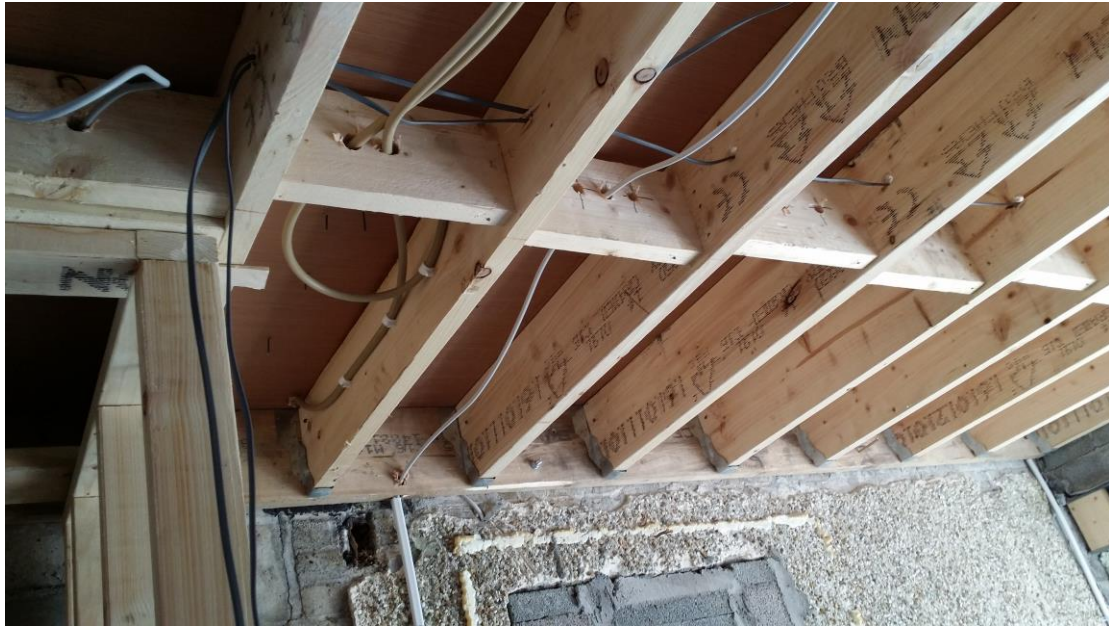
Verlegung von Kabeln
